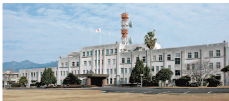
鹿屋基地庁舎
