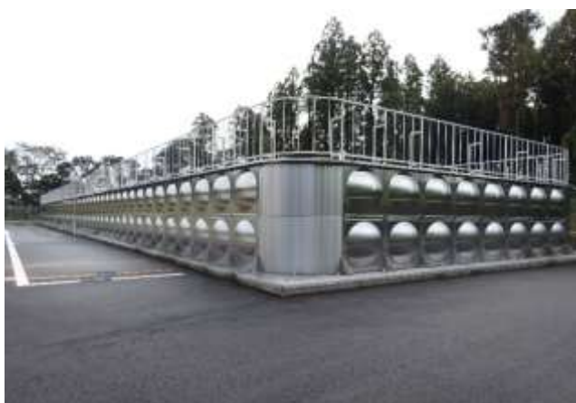
横山配水池 (平成 29 年 3 月完成)
