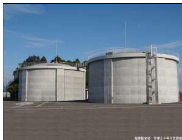
旭原配水池 (平成 24 年 3 月完成)
