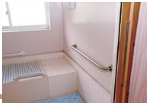
高齢者や障害者でも安心して利用できるように改造された浴室
