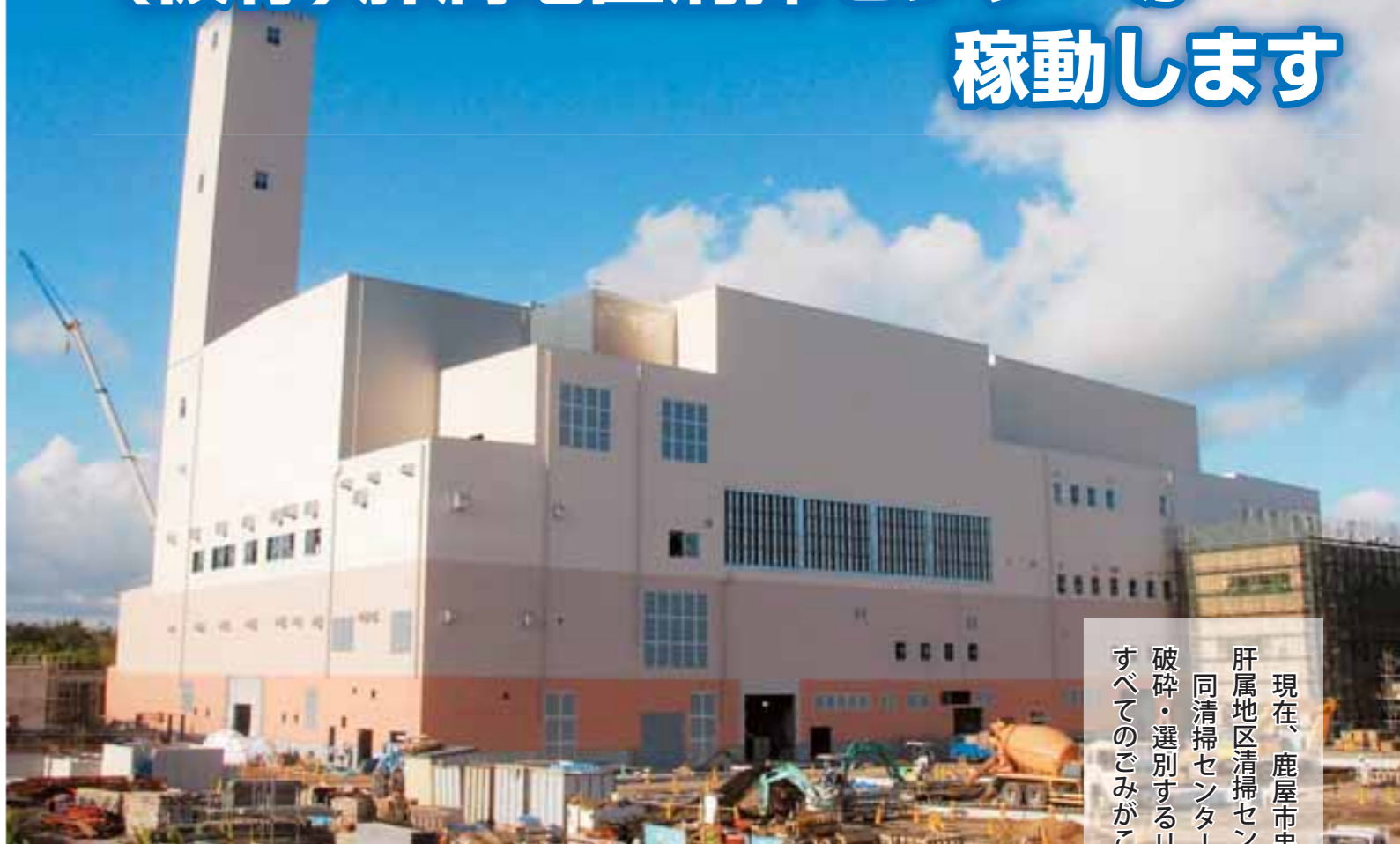
建設が進む新しいごみ焼却施設（仮称）肝属地区清掃センター
