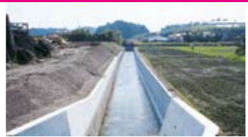
排水路整備事業により完成した「名貴地区排水路」
